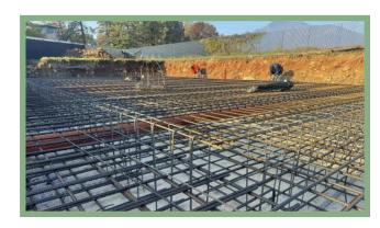
Sono in corso i lavori di realizzazione della platea di fondazione della struttura portante antisismica. L'edificio sarà adibito ad "edificio strategico" e la classe di appartenenza è stata individuata e progettata come "classe IV".
