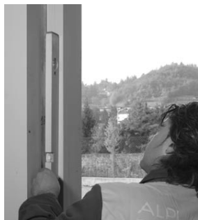
Figura: controllo del filo a piombo della spalletta di battuta.
