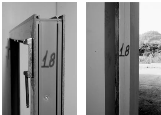
Figura: il codice riportato sul manufatto deve corrispondere con il riferimento del falso telaio e dell'abaco.
