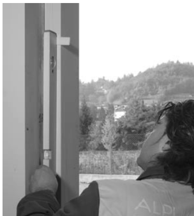
Figura: correzione del filo a piombo della spalletta.
