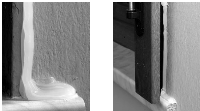
Figura: siliconatura della zona di battuta dell'aletta esterna del monoblocco.
