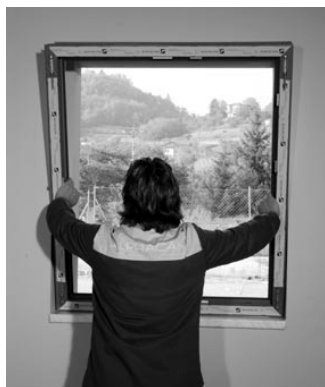
Figura: verifica del corretto accoglimento del telaio nel vano murario.
