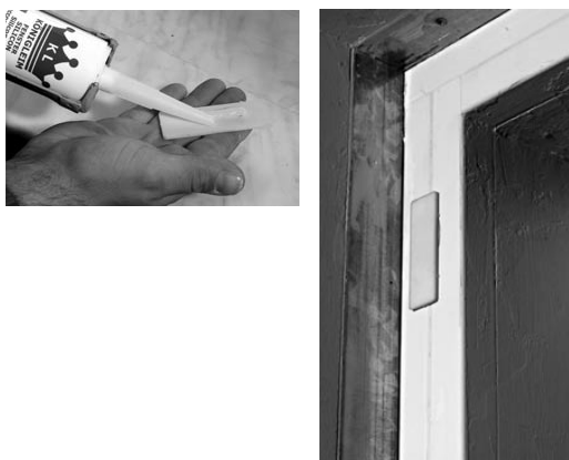
Figura: posizionamento dello spessore per la correzione del piombo.
