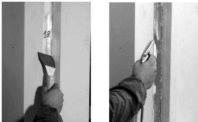
Figure: accurata pulizia del vano finestra.
