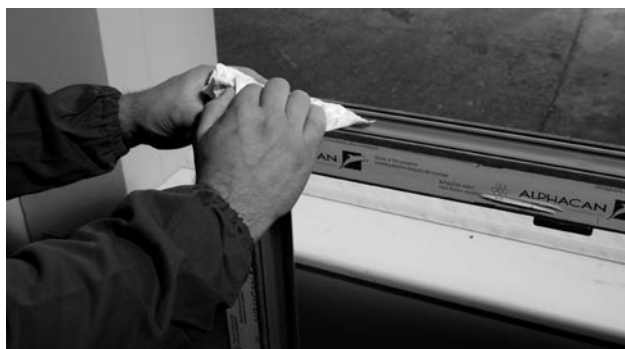
Figura: pulizia del telaio della finestra.
