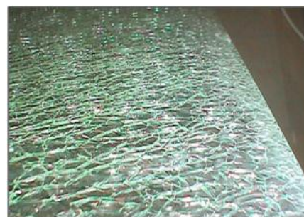
rottura di una lastra stratificata di
