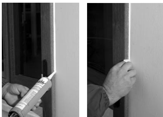
Figura: sigillatura perimetrale del monoblocco.
