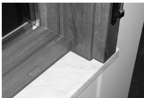
Figura: sigillatura dell'appoggio del monoblocco sul davanzale.
