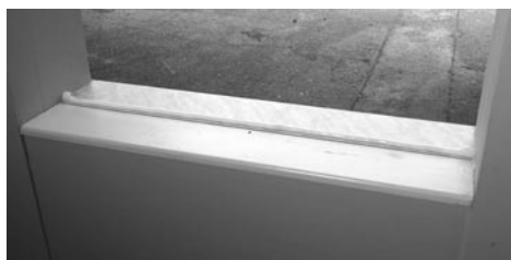
Figura: applicazione del cordolo di tenuta sul davanzale.
