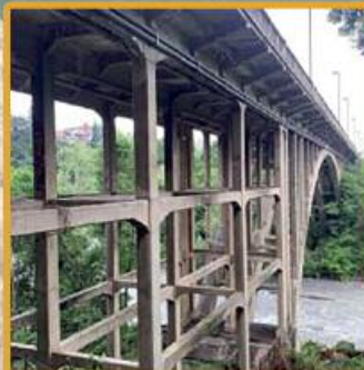
LAVORI PONTE NUOVO: MODIFICHE ALLA VIABILITÀ
