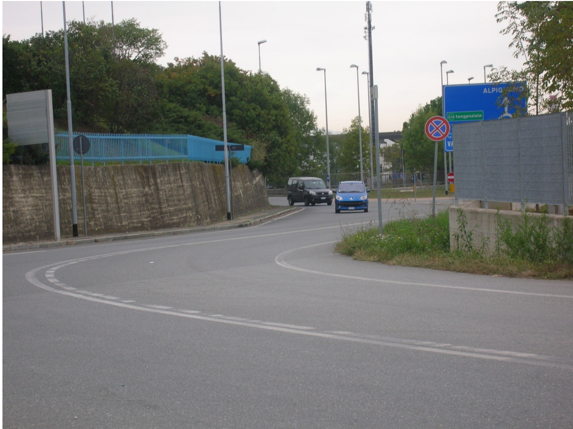
Vista dell'intersezione da via Grange Palmero
