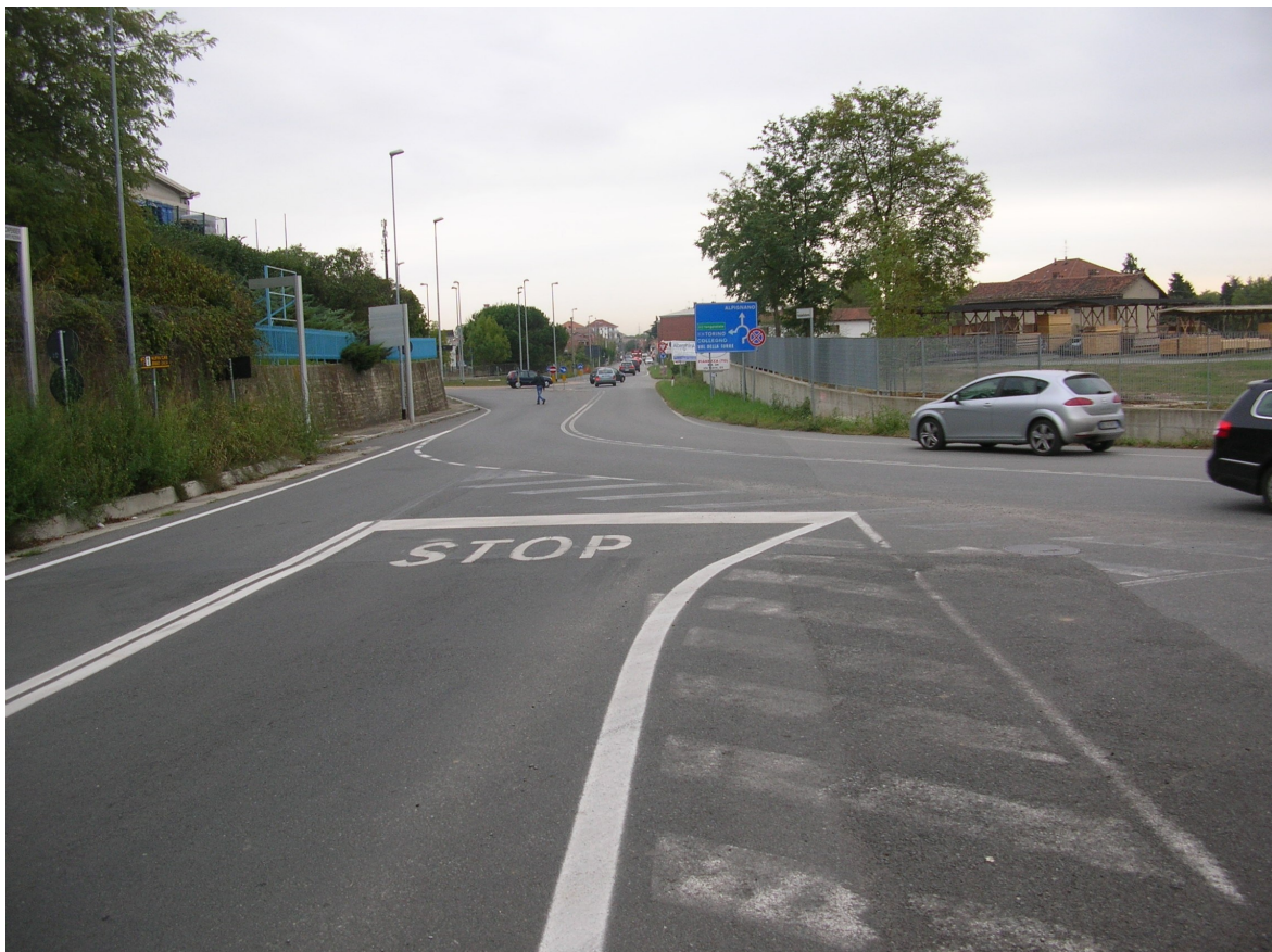
Vista dell'intersezione da via Valdellatorre in direzione del centro di Alpignano
