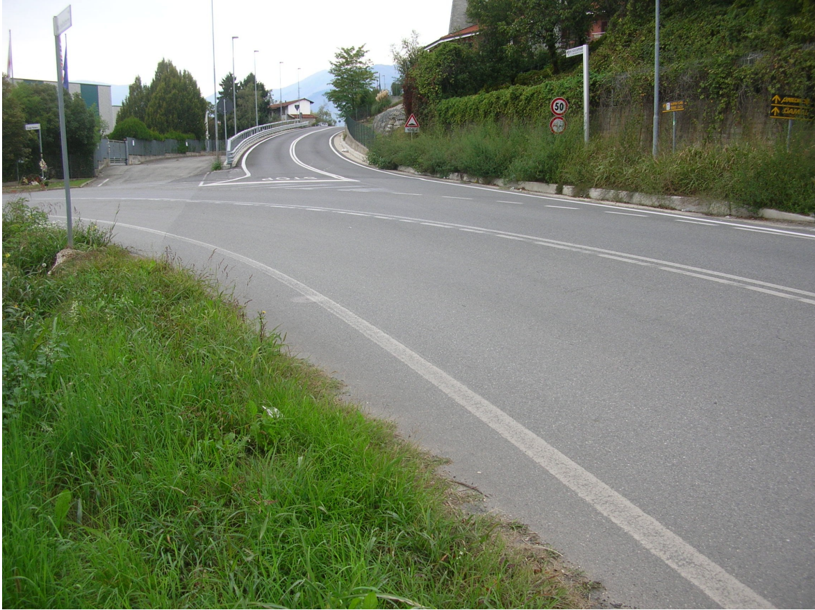
Vista dell'intersezione da via Valdellatorre in direzione del nuovo sovrappasso ATIVA.
