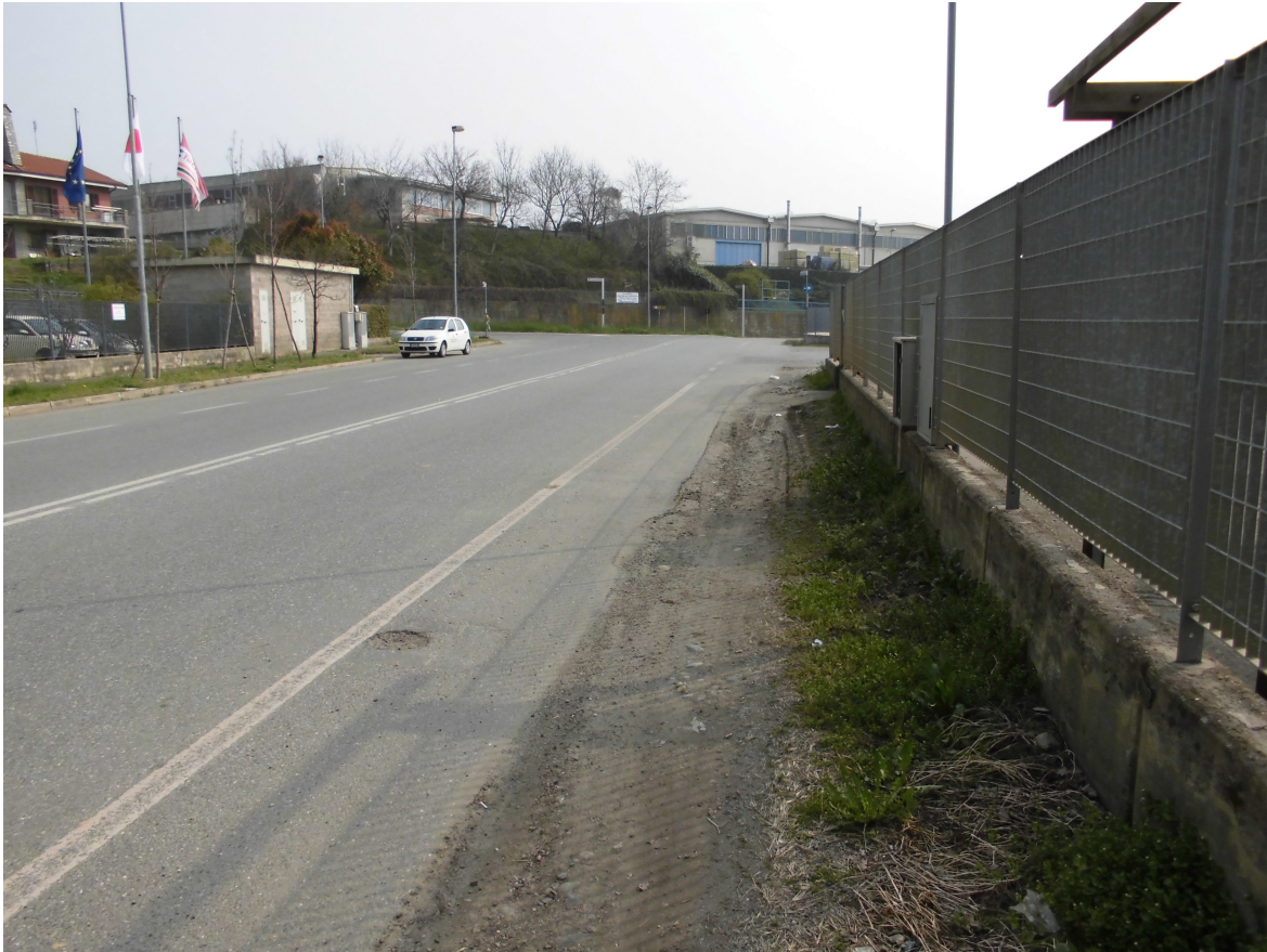
Vista dell'intersezione da via Grange Palmero
