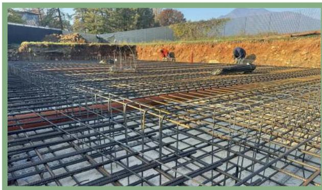
Sono in corso i lavori di realizzazione della platea di fondazione della struttura portante antisismica. L'edificio sarà adibito ad "edificio strategico" e la classe di appartenenza è stata individuata e progettata come "classe IV".
