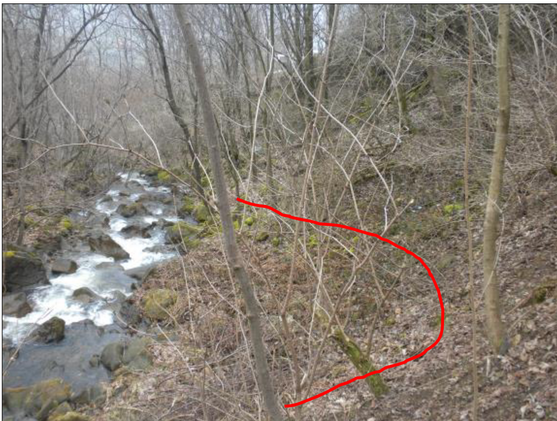
Fig. 6: – Vista da monte dell'alveo con evidenziazione con la linea rossa del limite di erosione al piede della scarpata che ha indotto la formazione della scarpata subverticale al coronamento
